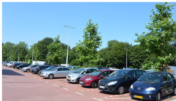
Parkeerterreinen Holendrecht West met nieuwe verharding en bomen
