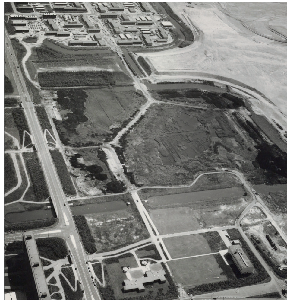
Foto aanleg dreef en fietspad
