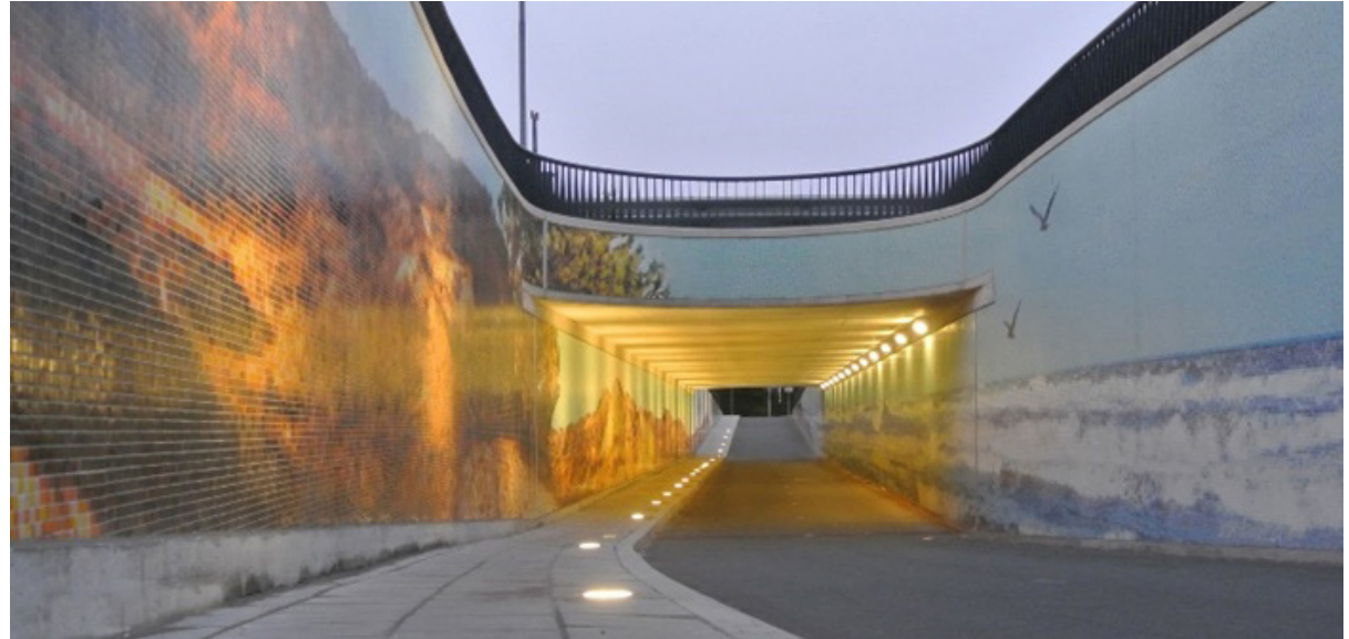
Referentie licht en kunst fiets- en wandeltunnel Den Deijl in Wassenaar
