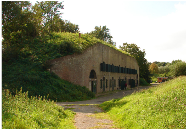
Fort 't Hemeltje, deels in gebruik als kantoorruimte
