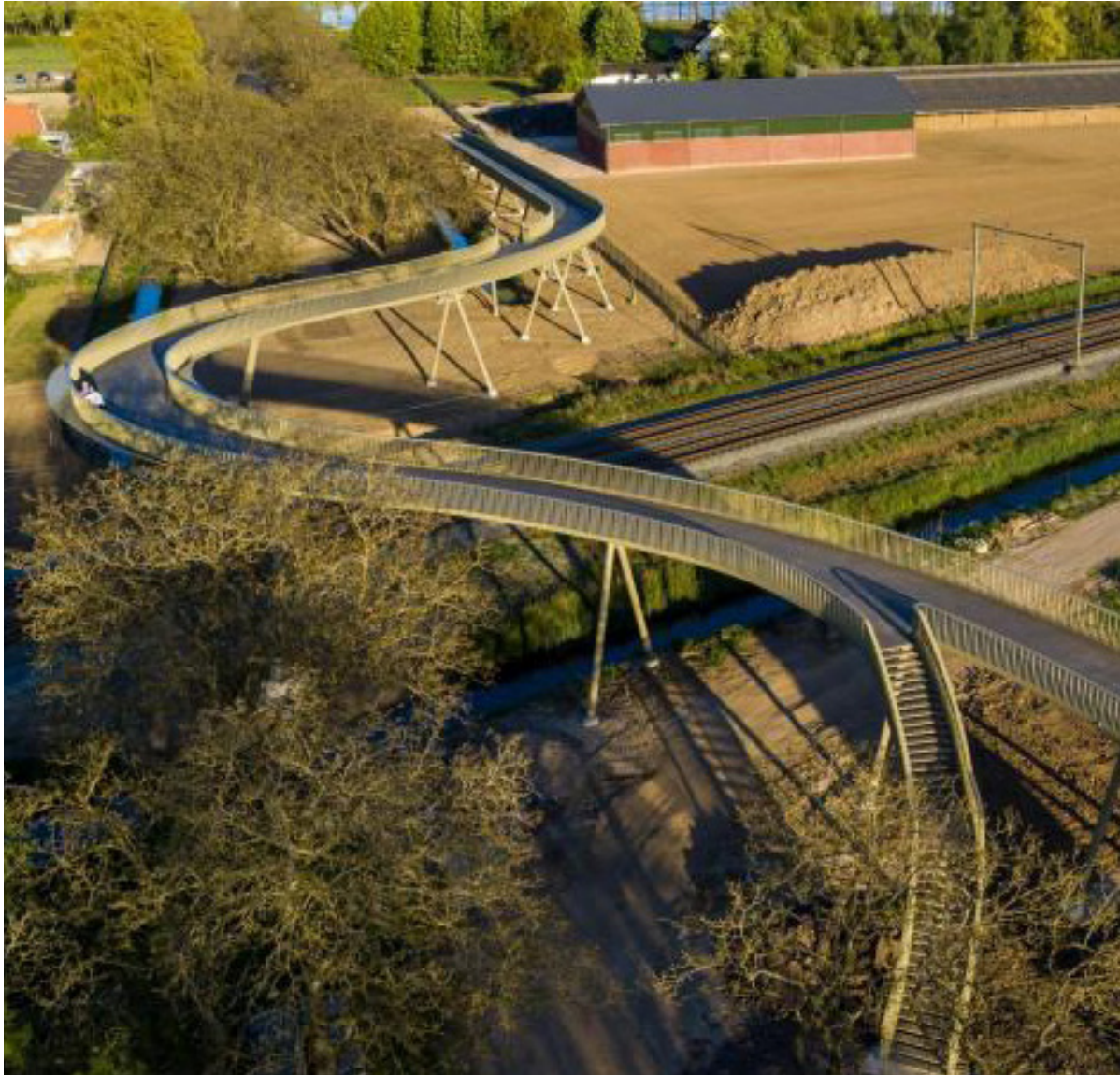
Referentie markante fietsbrug over het spoor: De Hoge Noot, Park Lingezegen
