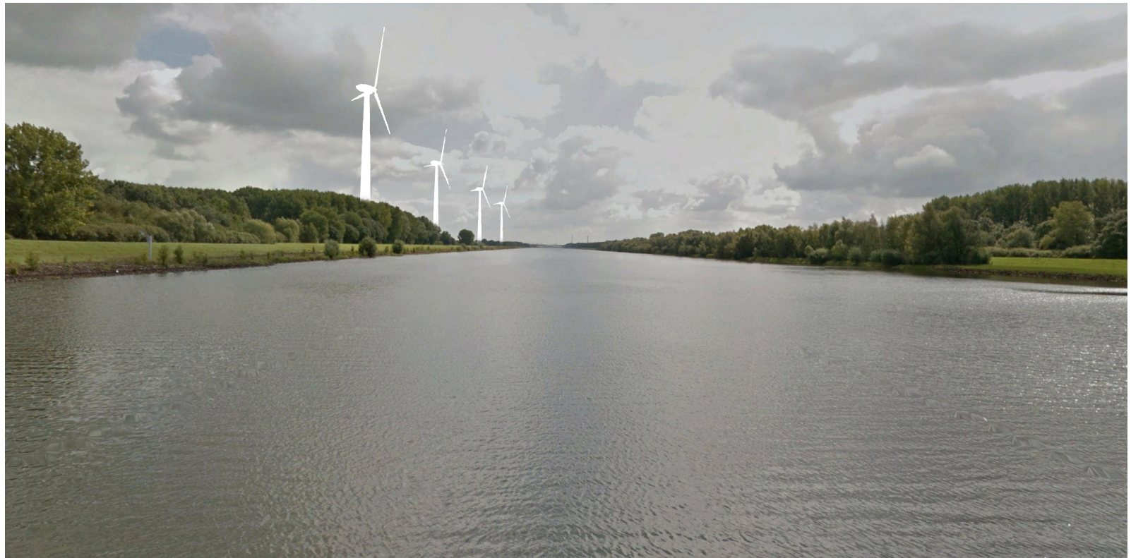
Turbines langs het kanaal vanaf de kanaalbrug
