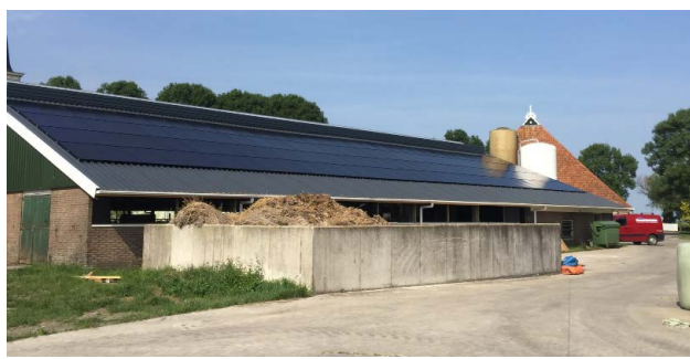
panelen vormen hier een net aaneengesloten vlak panelen vormen hier een net aaneengesloten vlak
