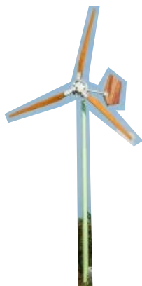
Houten molen 30.000 kWh tiphoogte: 21m 490 turbines nodig voor zelfde opwek van 1 grootschalige windturbine
